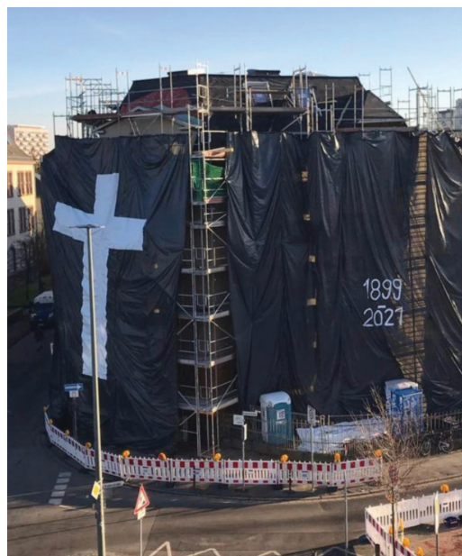
Haus in der Keplerstr. 1
